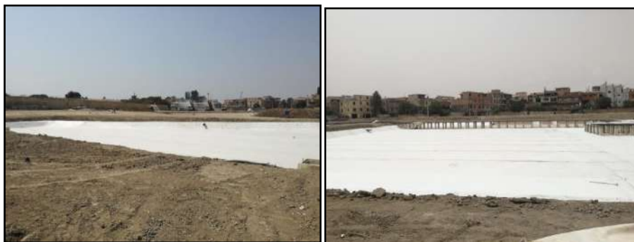
Figure 7. Photos mise en place du géotextile
