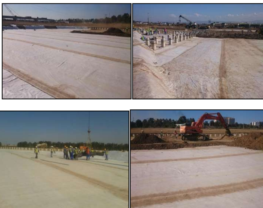
Figure 8. Photos de mise en place du GSB
